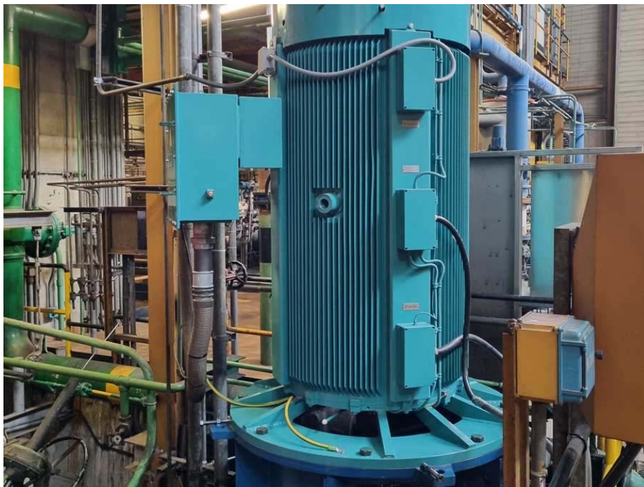
Bild: Menzel adaptierte den Pumpenmotor für die Anwendung – mit Spezialflansch und versetztem Hauptklemmenkasten
