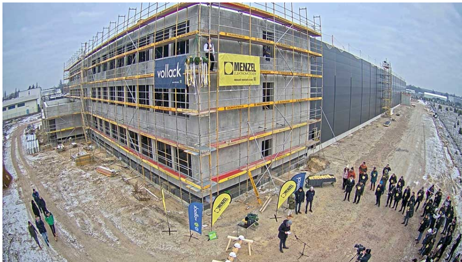
Bild: Der neue Hauptsitz von Menzel Elektromotoren soll im Sommer 2023 fertiggestellt werden
