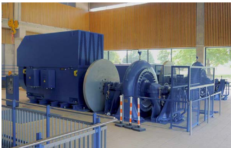
Bild: Die Landeswasserversorgung beauftragte Menzel, weil der Berliner Hersteller einen lagervorrätigen Motor in kürzester Zeit maßgeschneidert anpassen konnte
