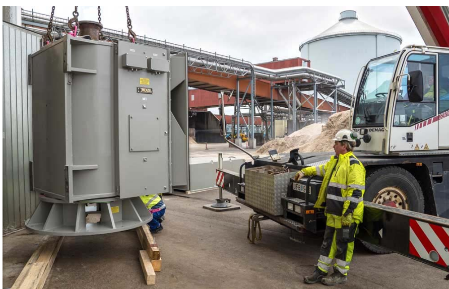
Bild: Damit die Zuckerverarbeitung weitergehen kann: Menzel hat einen Motor für die Vertikalaufstellung umgebaut und einen passenden Fuß gefertigt
