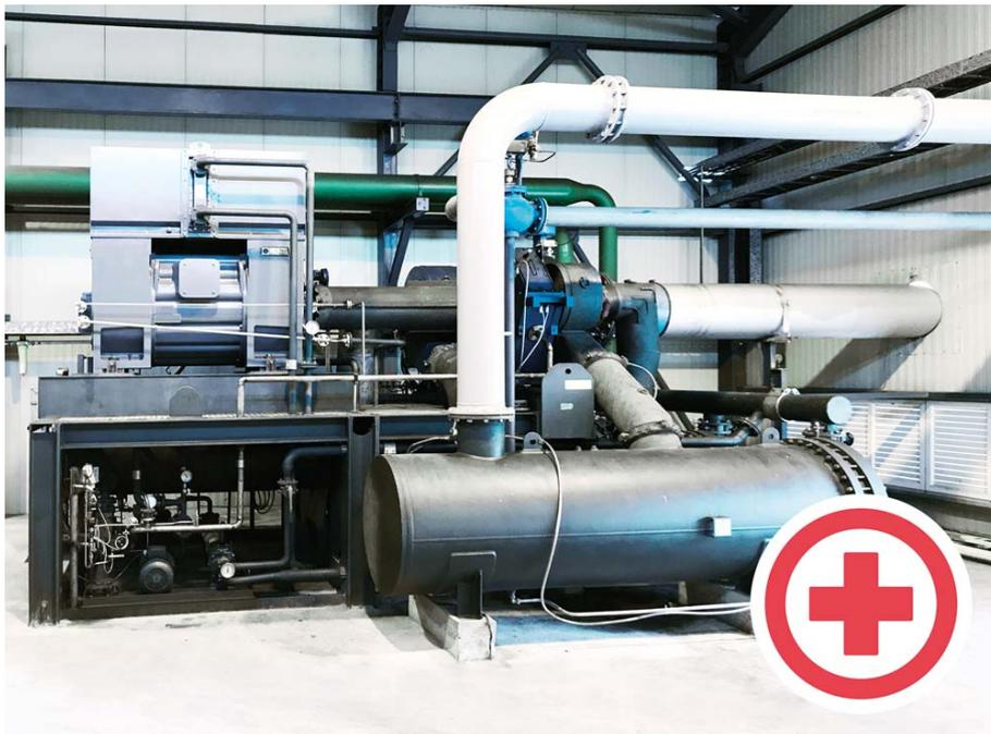
**Bild:** Der Ersatzmotor bei der Inbetriebnahme vor Ort.
